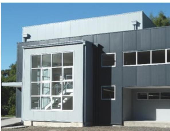
El edificio tiene una superficie de 496 m<sup>2</sup>, estructurado en acero en sus dos niveles. En el primer nivel se incluye una planta piloto, bodegas de materiales, instrumentos, equipos, taller de herramientas y mecánico, servicios
