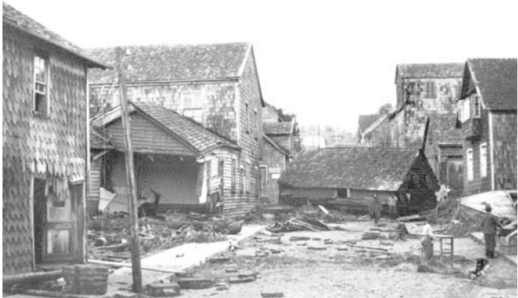
Fotografía de la portada: En Maullín, Chile, muchas construcciones soportaron el terremoto de magnitud 9,5 del 22 de mayo de 1960; sin embargo, no fueron capaces de resistir la energía de las olas del tsunami. La casa, que se observa en medio de la calle, fue transportada allí por la segunda ola del maremoto.
