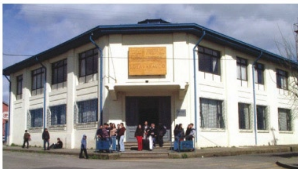
Casa Central CFT Lota-Arauco.
