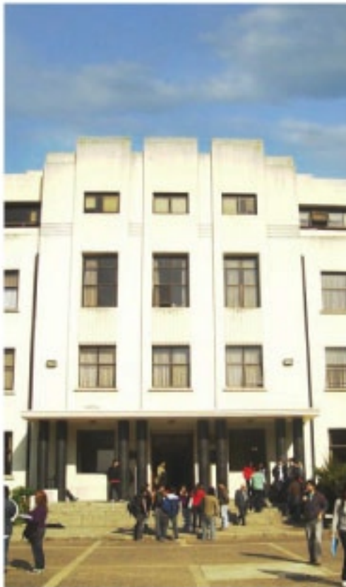
Edificio de la Facultad de Cs. Jurídicas y Sociales
